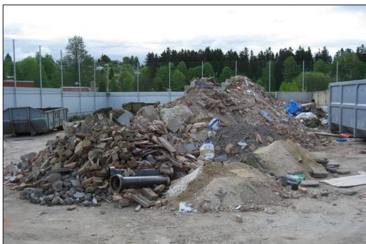
Obrázek 11 – Stavební a demoliční odpad – ilustrační foto
