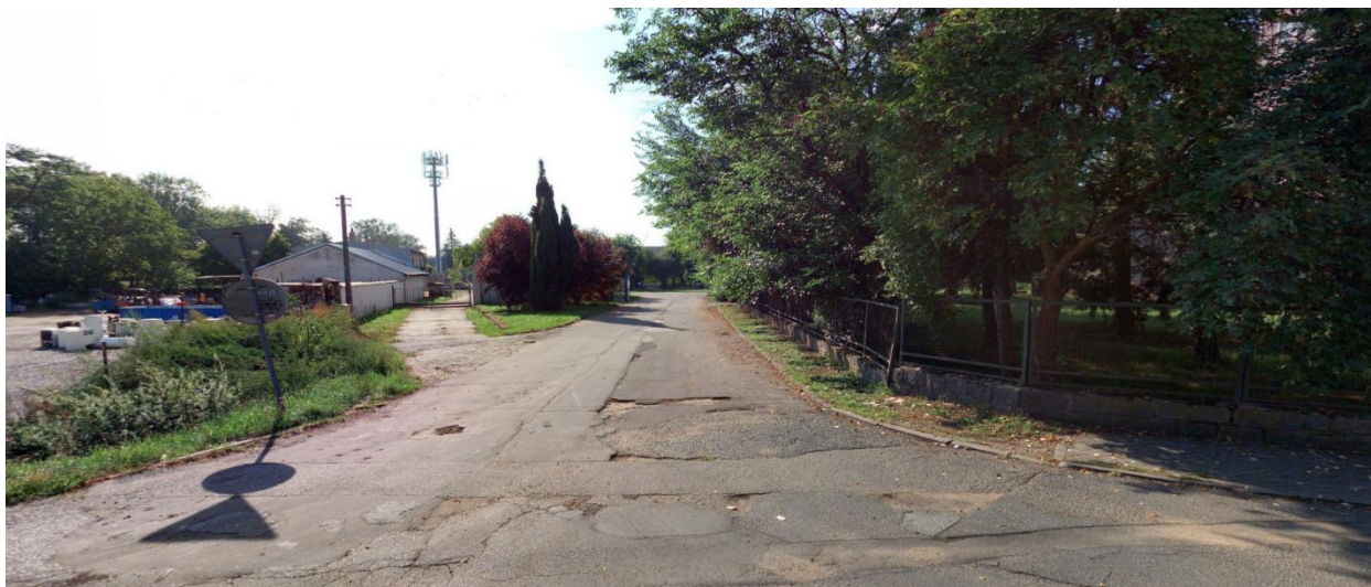
Foto č. 6 ulice k Nádraží stávající sjezd do soukromého areálu „Šubrt Transport.sped s.r.o.“ a účelová komunikace
