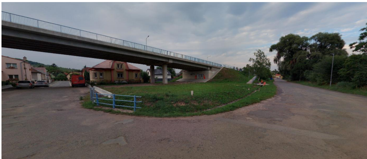
Foto č. 8 ulice Slévárenská v místě stávajícího silničního nadjezdu
